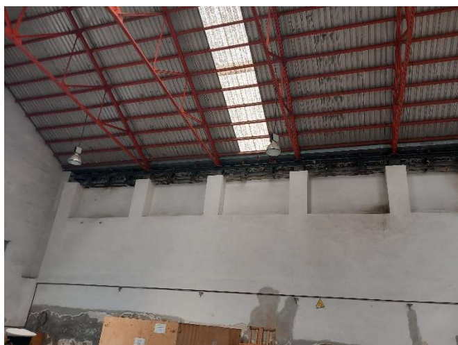
Figura 1 e 2 – Vista dei lucernai dall'interno dell'edificio C13A
