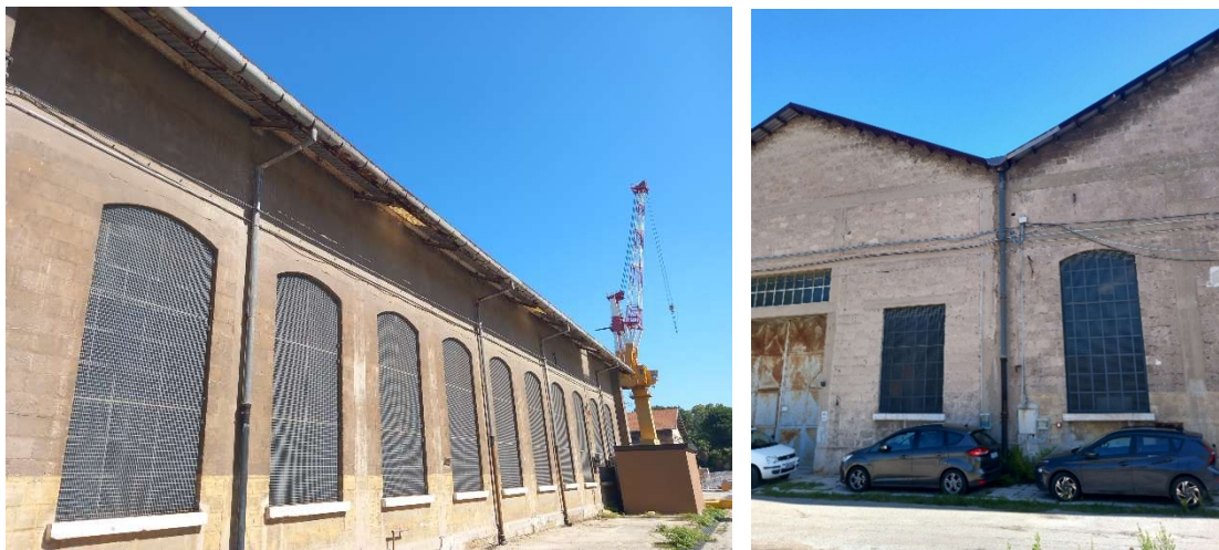
Figura 5 e 6 – Vista dei canali di gronda e dei discendenti in lamiera dell'edificio C13A
